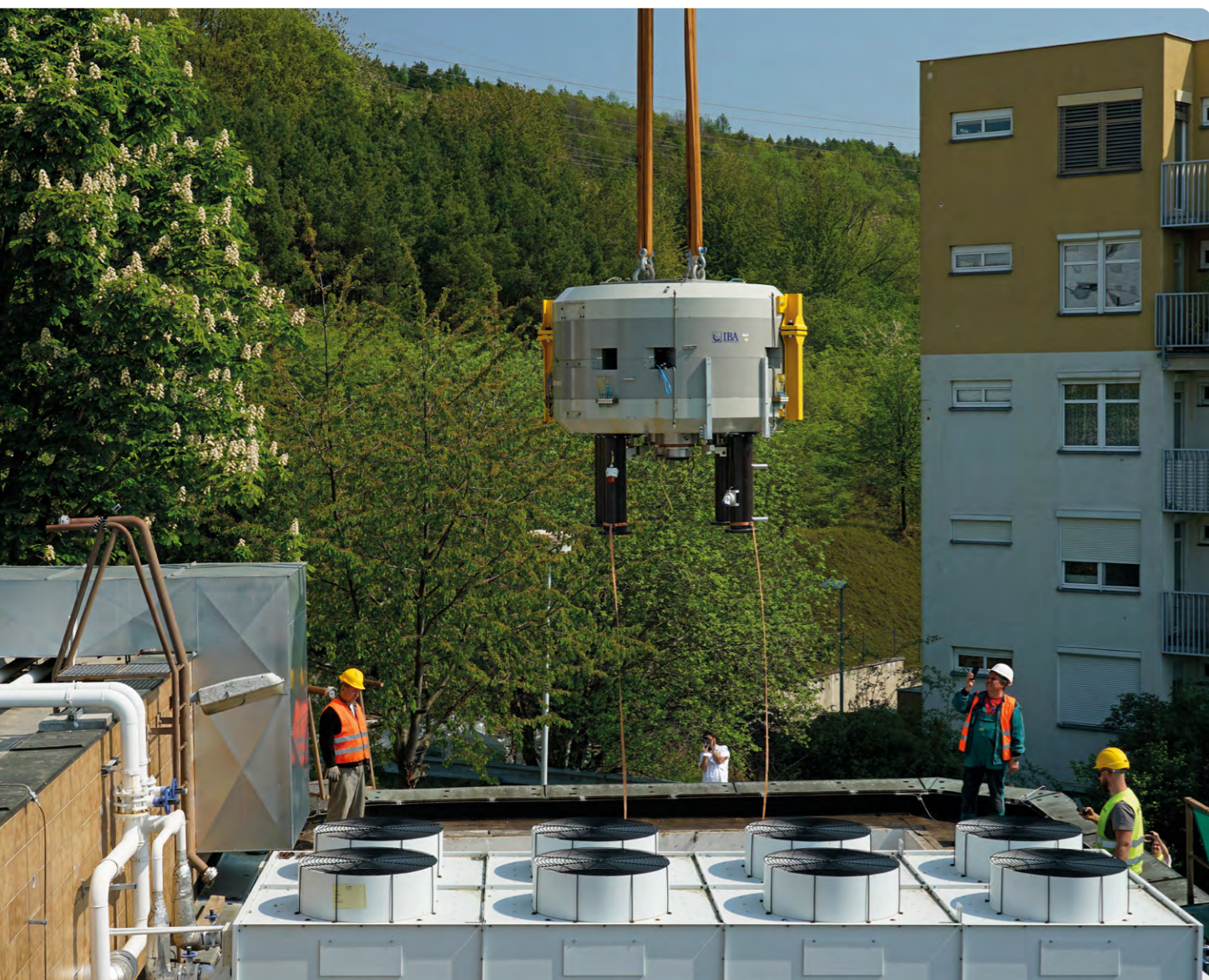
Obrázek: Vyzvednutí původního cyklotronu střechou
