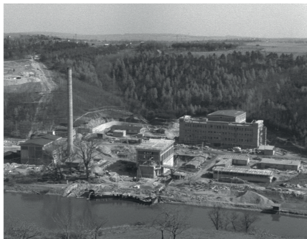
Stavba Ústavu jaderné fyziky v Řeži
